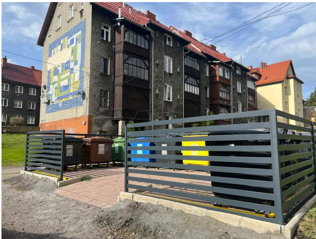
Fot. 15. Boks śmietnikowy na pojemniki do selektywnego zbierania odpadów tzw. „gniazdo” przy ul. Krakowskiej w Boguszowie-Gorcach.
